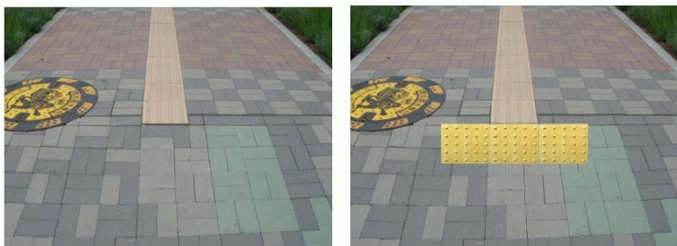
誘導ブロックの端には警告ブロックが必要です。
